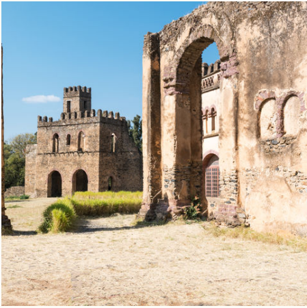
Alte Gebäude im Kaiserviertel in Gondar, Äthiopien
