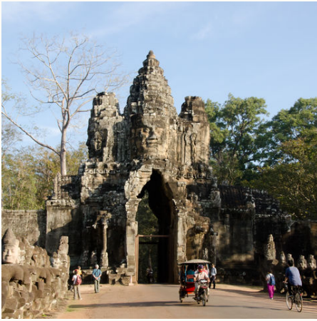
Eingang von Angkor Thom, Kambodscha
